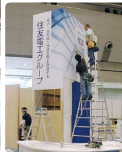
●ブースのシンボルタワーの建て込み
