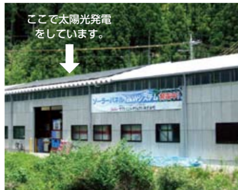
●奈良第3工場ルーフのソーラーパネル
